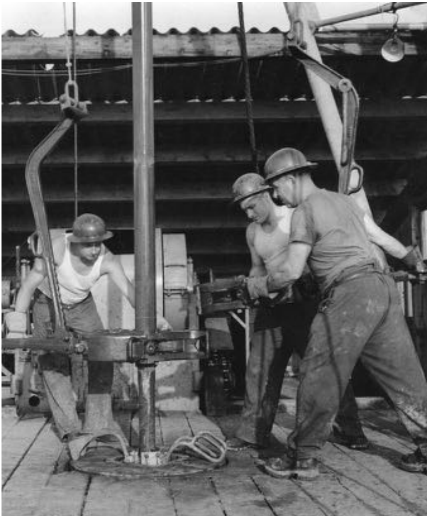
Salzbohrung: Rotary- oder Dreh- bohrverfahren, Verschraubung des Bohrgestänges, 1955.
